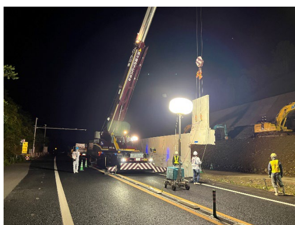
＜仮設防護柵設置＞
