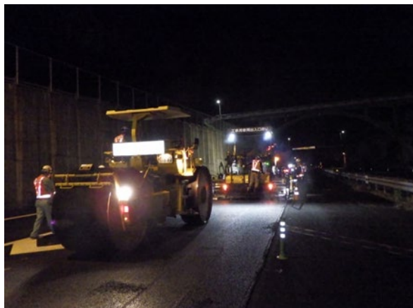
＜舗装補修工事＞
