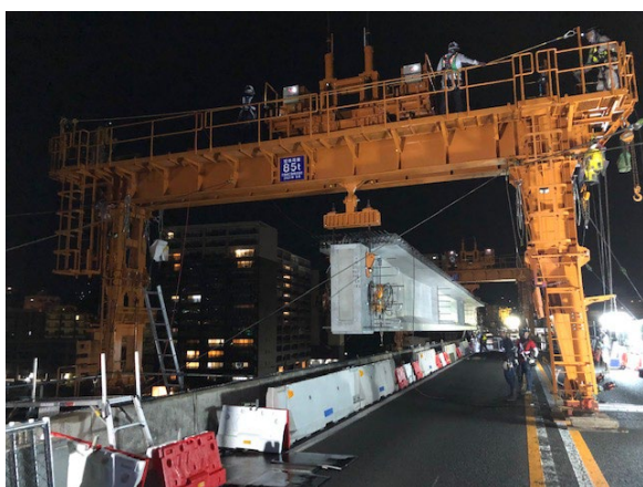
＜橋梁桁架設＞
