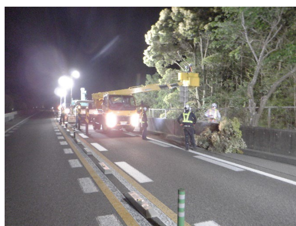
＜樹木伐採作業＞
